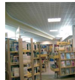
Panneaux absorbants sur le plafond d'une médiathèque
