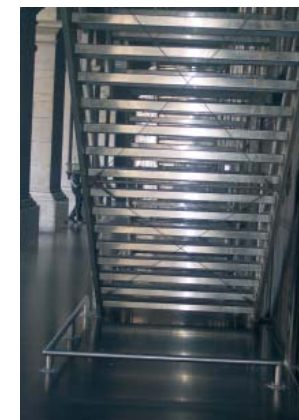
Rappel tactile au sol pour signifier la présence d'un escalier
