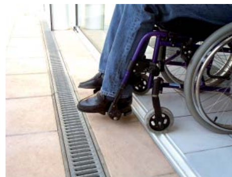
Un accès à la terrasse avec un seuil encastré
