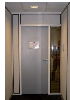
Repérage facilité par une paroi vitrée à proximité de la porte
