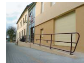
Une rampe d'accès accessible à tous
